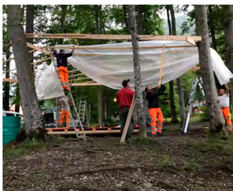
Überdachung ist angesagt
