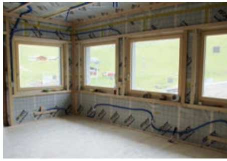
Der Innenausbau kommt voran
