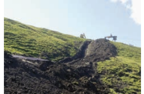
Guter Baugrund im Hintertschuggi
