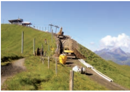
Hochalpine Baustelle beim Alpen tower
